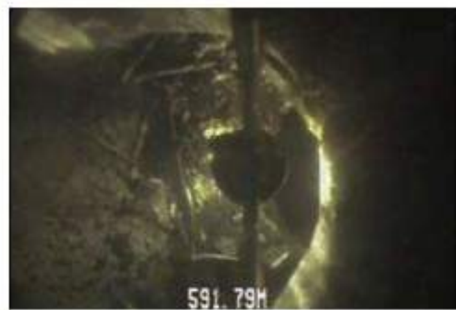
Figura 9 – Dano observado no poço M#23 – vista de topo
