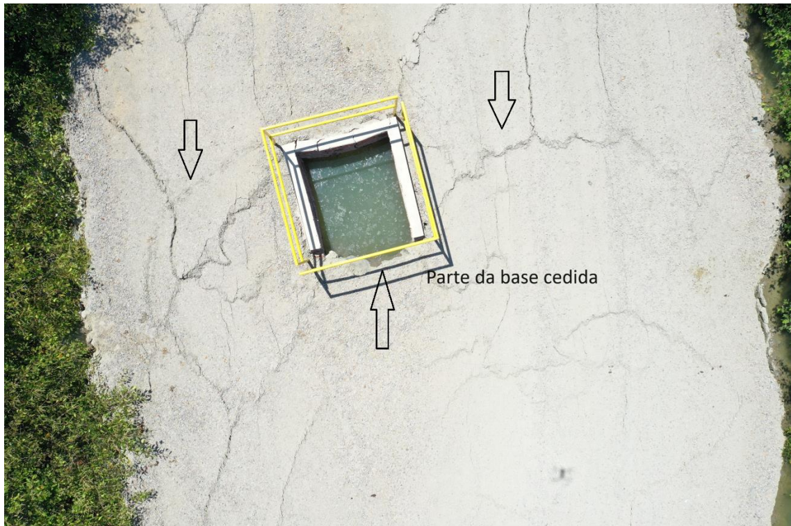
Figura 6 - DIA 29. Registro da boca do poço da cavidade 18. Fraturas ao redor da base intensificadas. Parte da base cedida.
